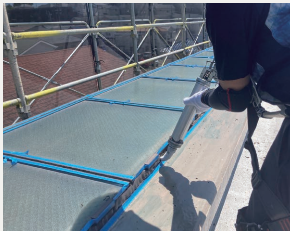
シーリング工事 ※部位や用途によって、充填するシーリング材が異なります。
