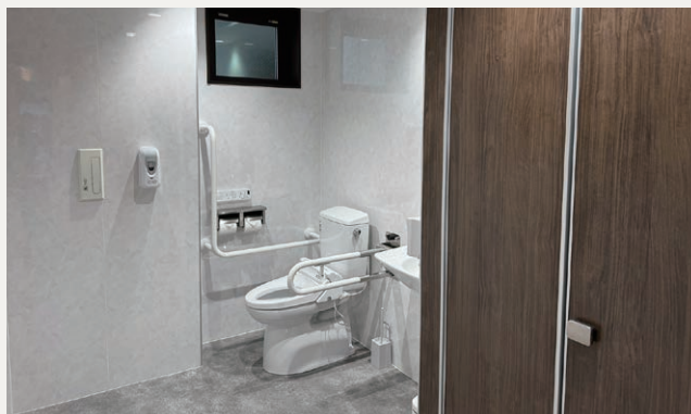
多目的トイレ改修工事
