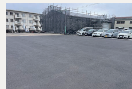
アスファルト舗装工事
