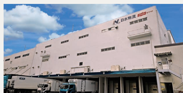
福岡県福岡市 日本物流株式会社 箱崎物流センター 外壁塗装 4,895㎡ 屋根塗装 420㎡
