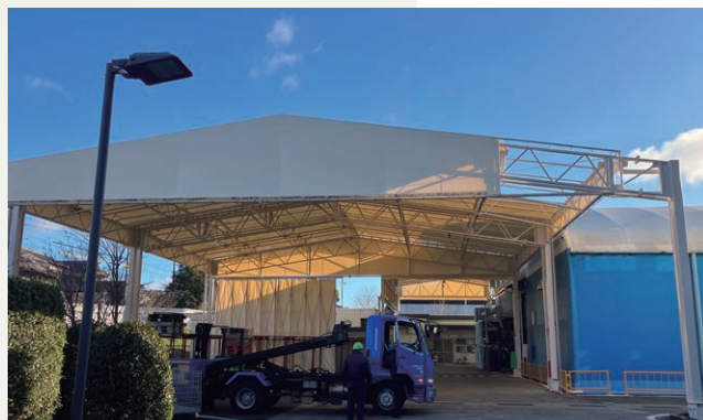
テント倉庫工事
