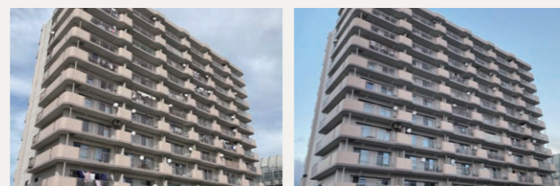
愛知県名古屋市中村区マンション(66戸) 大規模修繕工事
