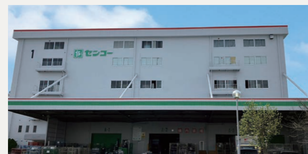
埼玉県戸田市 センコー株式会社 戸田第1PDセンター1号 外壁塗装 2,924㎡ 屋根塗装 2,468㎡
