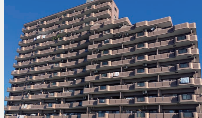
岐阜県各務原市マンション(79戸) 大規模修繕工事
