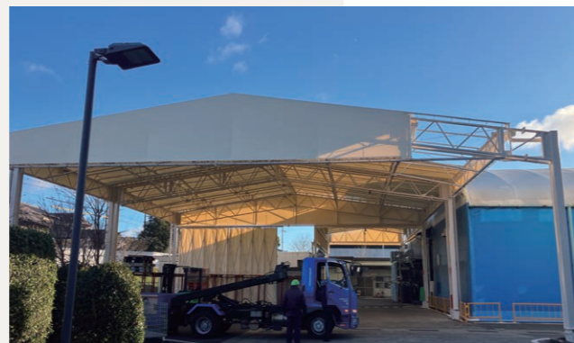
テント倉庫工事 テント新設・生地更新(生地・遮熱・防災シート)
