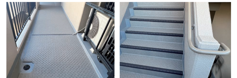
愛知県名古屋市中村区マンション 廊下・階段 長尺シート敷設工事
