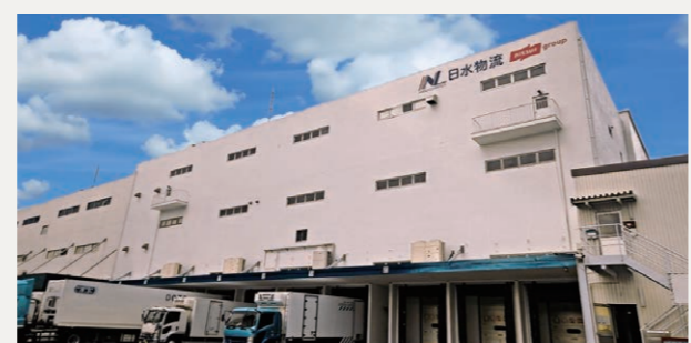
福岡県福岡市 日水物流株式会社 箱崎物流センター 外壁塗装 4,895㎡ 屋根塗装 420㎡
