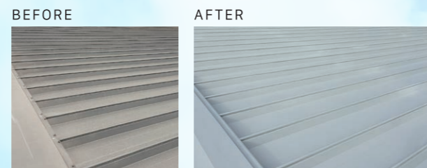
東京都青梅市 株式会社タチエス 青梅工場 屋根遮熱塗装 4,391㎡
