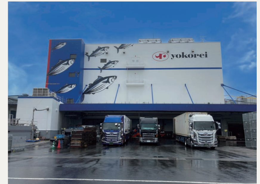
宮城県気仙沼市 横浜冷凍株式会社 気仙沼ソーティングスポット 外壁塗装 4,398㎡ 屋根塗装 972㎡
