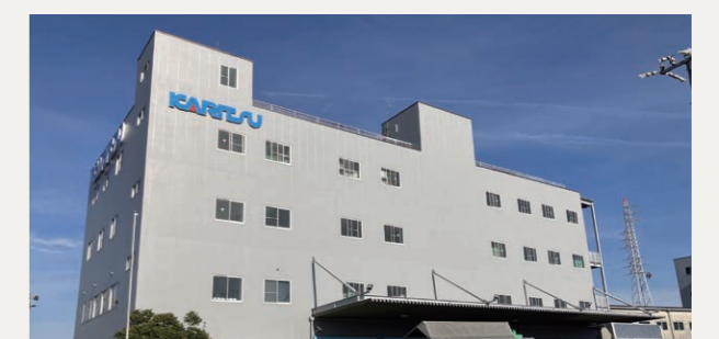
愛知県安城市 カリツー株式会社 デバイスセンターA棟 外壁塗装 1,900㎡
