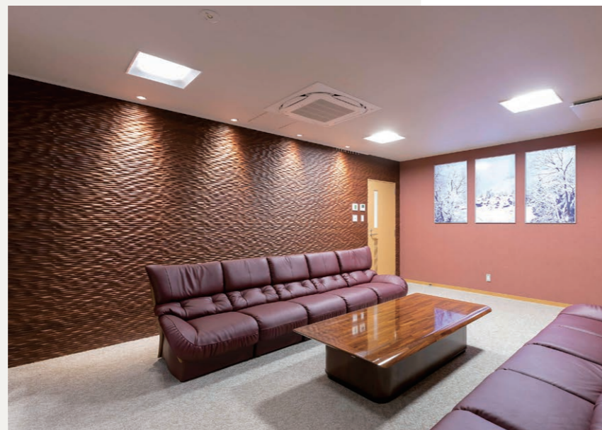
内装工事 照明器具(LED化)クロス張替・壁デザインパネル張り
