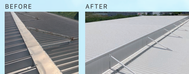
長野県千曲市 日本梱包運輸倉庫株式会社 千曲営業所八幡倉庫 屋根遮熱塗装 12,134㎡
