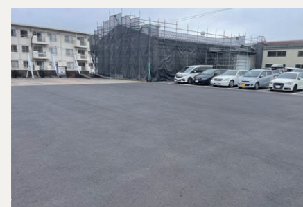
アスファルト舗装工事 舗装打替(アスファルト2層・半たわみ)
