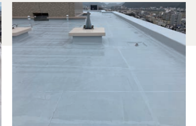
岐阜県岐阜市マンション 屋上防水工事 改質アスファルトシート 700㎡
