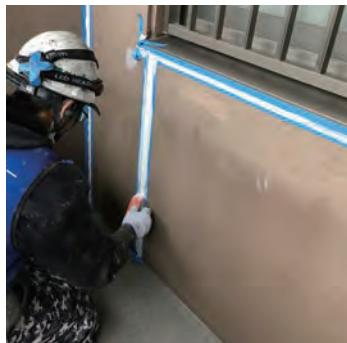
建物に施してあるシーリング材を打ち替えます。打継目地やサッシまわり等、各所に施工し、内部への漏水を防ぎます。
