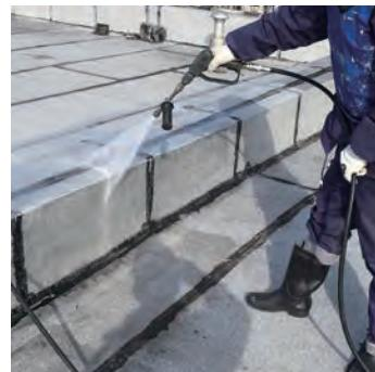
洗浄工事では、高圧水にて外壁や床に付着している長年の汚れやコケ等を除去し、その後に施工する塗装や防水塗膜の密着性を高めます。
