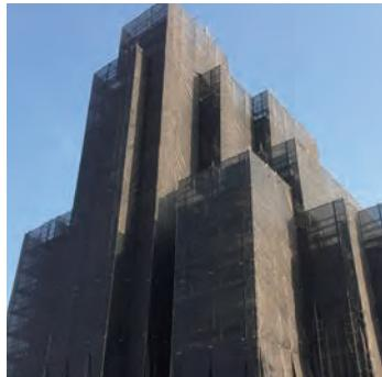
工事に必要不可欠な外部足場を設置します。仮設計画を行い、安全にも十分に配慮した上で、作業します。
