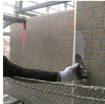
外壁等の不具合部を補修します。建物全体を調査し、劣化箇所を特定。発生している劣化現象(ひび割れ・欠損・浮き等)に適した工法で補修します。
