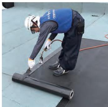
屋上・屋根・庇・ベランダ・廊下等、建物の各所にある部分を防水処理します。居住空間・生活を守る重要な工事です。施工する場所や形状により、適切な工法を選定し、防水処理していきます。
