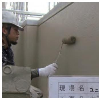
外壁の塗装や磁器タイル面への撥水処理を行います。塗装面については、既設色からの色替えも可能です。仕様にもよりますが、下塗り・中塗り・上塗りと工程を経て仕上げていきます。
