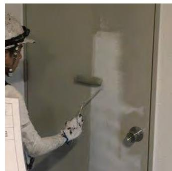
パイプシャフトの扉や電気盤等の鋼鉄部分を塗装します。既設の錆を落とし、下塗りとして錆止めを塗布した後、上塗りを進めます。
